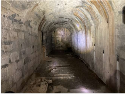
上半円下方形欧風窓型隧道
